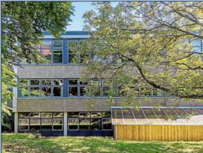
Energetische Sanierung Realschule
