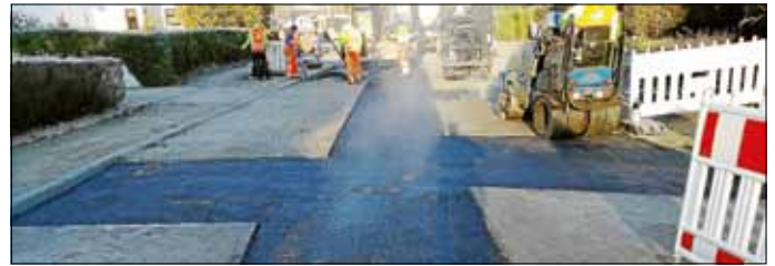
Einbau Tragschicht in der Gartenstraße
